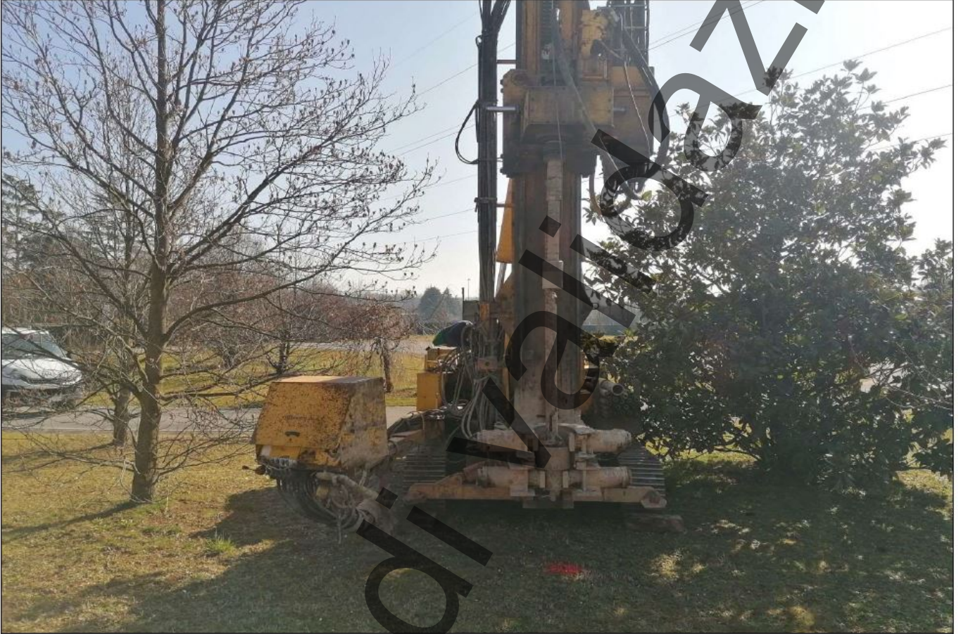
Posizionamento su sondaggio PIM.LS.03
