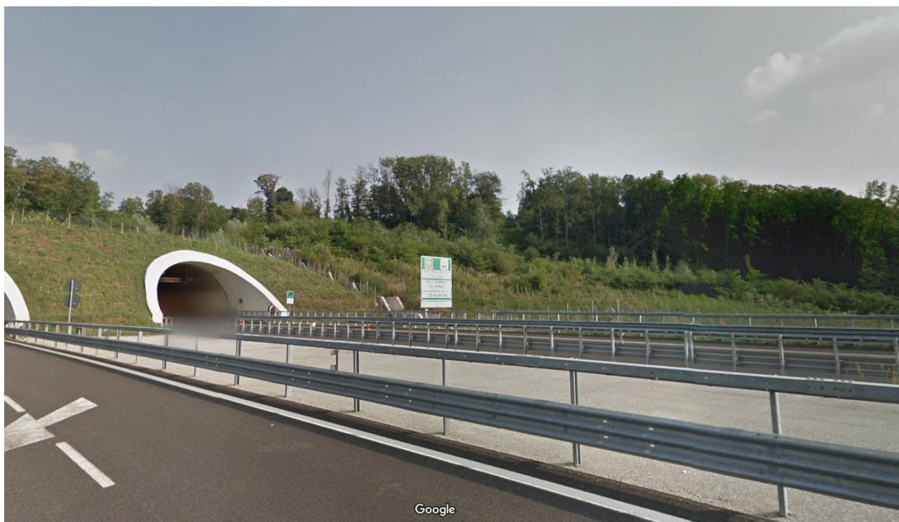
Figura 5 – opere a verde presso l'imbocco della galleria Morazzone (lato Gazzada)
