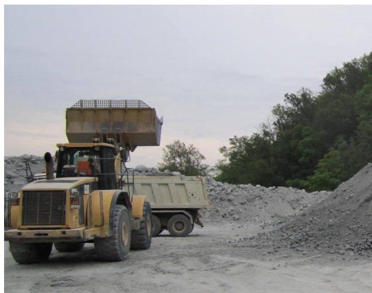
Fotografia 2 – Area di deposito smarino galleria Morazzone presso C.O.V1
