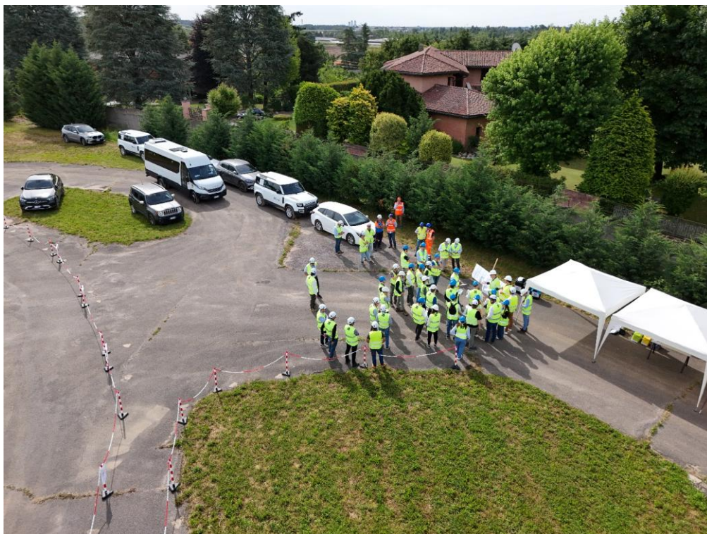
Interventi e attività tecniche sulla rete elettrica nell'ambito della gestione delle interferenze con i cantieri delle tratte B2 e C. Foto: Terna.
